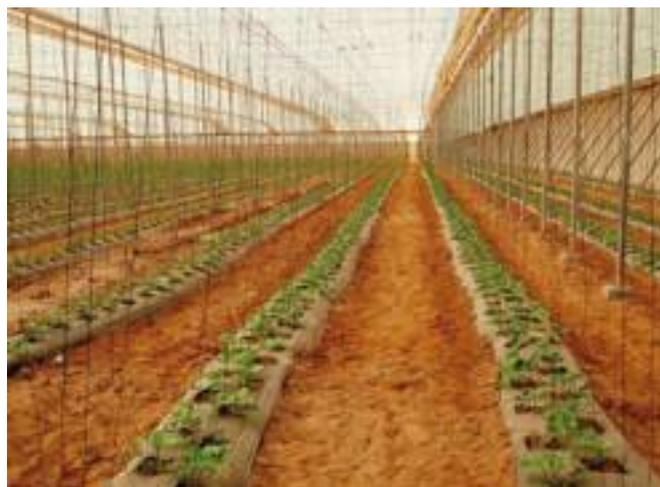
**Il modello di serra prevalente in Marocco è rappresentato dalla cosiddetta "canariana", molto simile al "parral" spagnolo, ovvero una tensio-struttura a tetto piano, di notevole altezza (5-6 m), con aperture di colmo e laterali protette da reti anti-insetto.**
